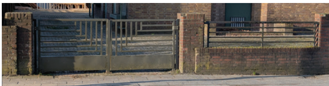
Het schakelhuis aan de Lanxmeersestraat, ontwerp Hendrik Fels, en een detail van het spijlenhek. Theo Boersema, Culemborg
