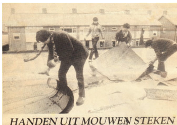
Sloop van het dak van het ketelhuis. Utrechts Nieuwsblad, 4 maart 1985
