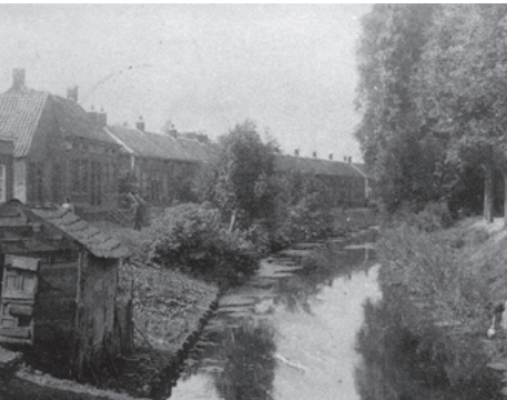
Talud langs de Hucht
