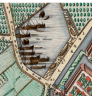
De haven (tegenwoordig 'Ronde Haven' geheten) met op het land schepen in aanbouw of reparatie. Scheepvaartmuseum, Amsterdam
