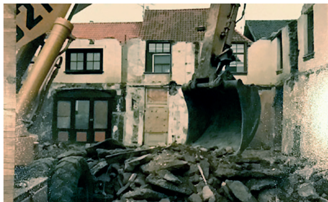
Tijdens de restauratie van binnen richting Achterstraat gekeken. Architectenbureau Wim en Adrienne Mazzola
