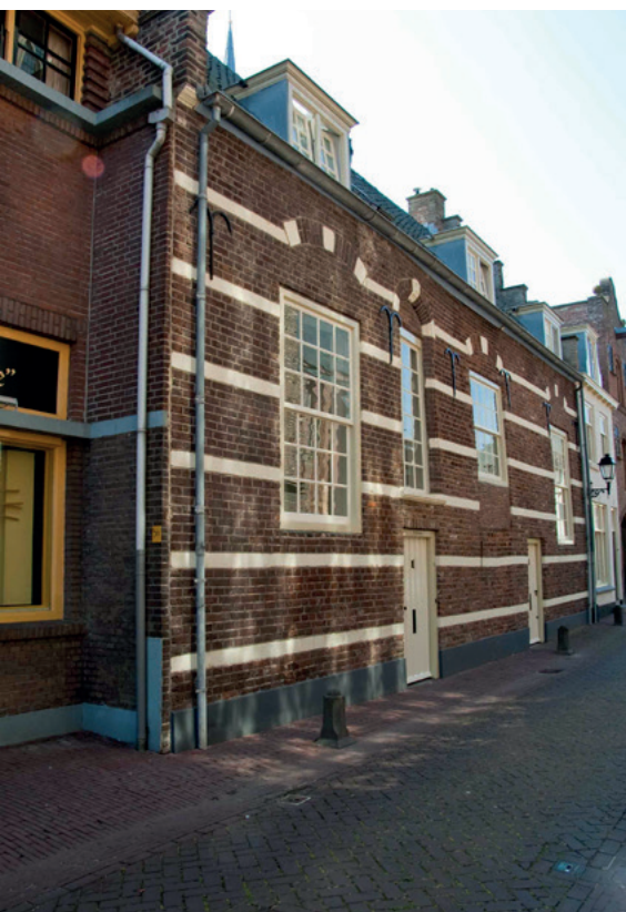
De Dekenije na de restauratie. Louis Hoek
