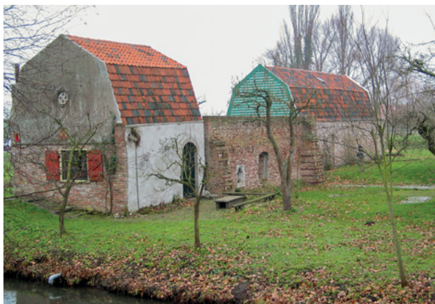
Resten van de oorspronkelijke muur zijn onderdeel van de schuren op het terrein. Foto uit 2003. Albert Speelman/RCE 13755
