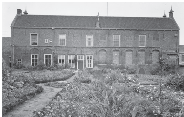
De achtergevel in 1948 (links). In 1979 wordt de achtergevel van de westvleugel gerestaureerd door Henk van der Wielen (rechts, situatie 21e eeuw) RCE 040257 | Marion Golsteijn/Wikipedia
