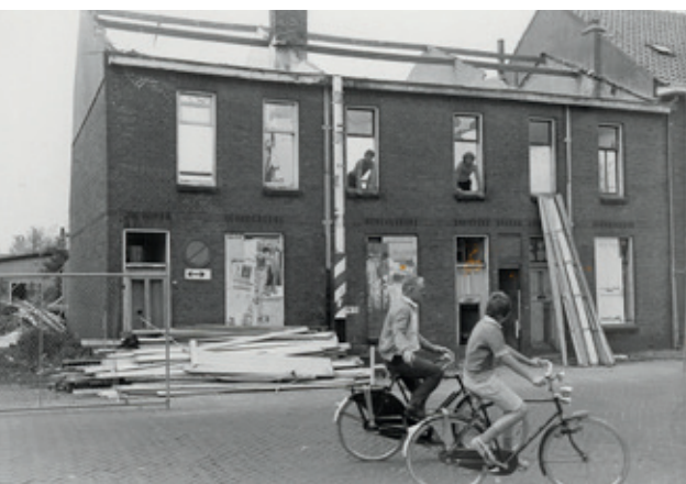
Voor de aanleg van de Boerenstraat, die er alsnog komt, worden in 1979 woningen aan de Prijessestraat gesloopt. Regionaal Archief Rivierenland, Tiel
