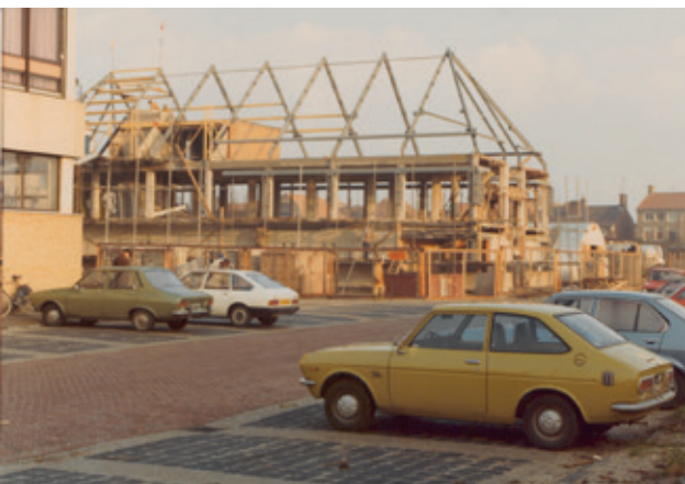
Het hoogste punt van het nieuwe politiebureau is bereikt. Het zou 40 jaar dienst doen en werd afgebroken met het verdwijnen van de gemeentepolitie in 2009. Foto gemaakt door C. van Barneveld in de tweede helft van de jaren 1970. Regionaal Archief Rivierenland, Tiel
