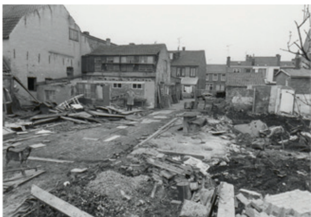
In de omgeving van de Nieuwstraat wordt gesloopt om ruimte te maken voor het nieuwe politiebureau. Regionaal Archief Rivierenland, Tiel
