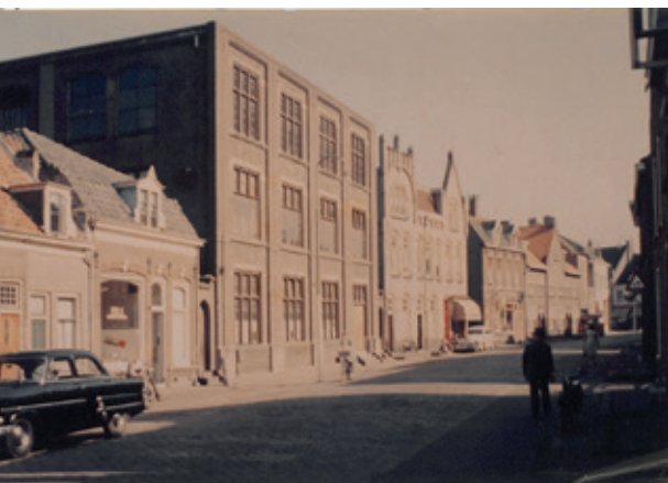
De 'Imprimatur' is een fabriek voor sigarenkistjes die al enkele jaren leegstaat. Na de oorlog is het pand korte tijd gebruikt door de textielfabriek Spencer-Heij. Regionaal Archief Rivierenland, Tiel
