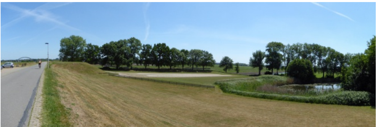
De inlaatsluis lag in de dijk; waar nu de betonnen parkeerstroken liggen was een sluisolk.
