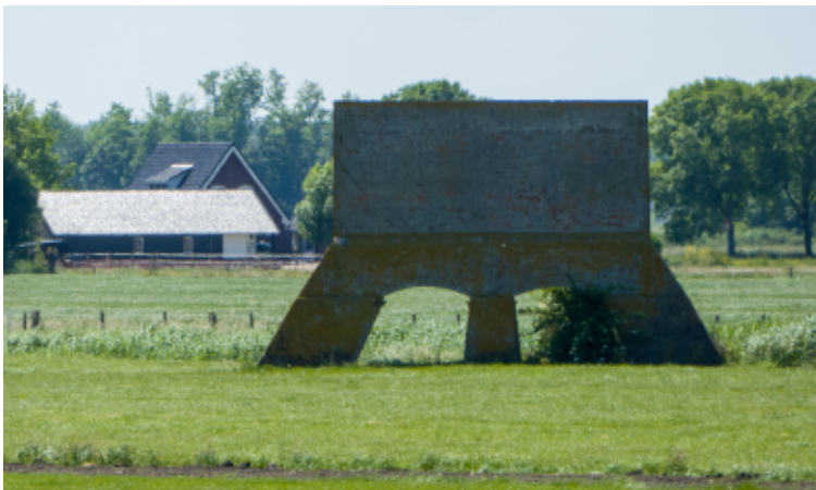
Een merkwaardig object in het land achter het Werk aan het Spoel is de kogelvang. Hij is gebouwd rond 1880 van baksteen. De bijbehorende schietbaan is verdwenen.
