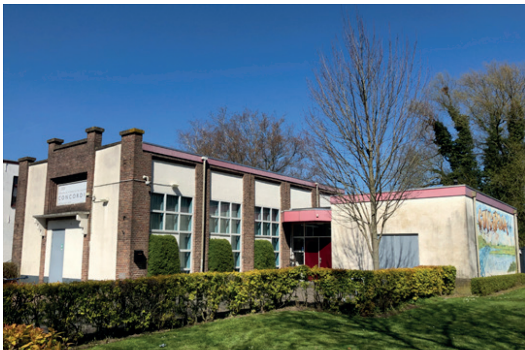
Het gebouw van Concordia aan de Westersingel anno 2019. (foto Lorena Rijksen)
