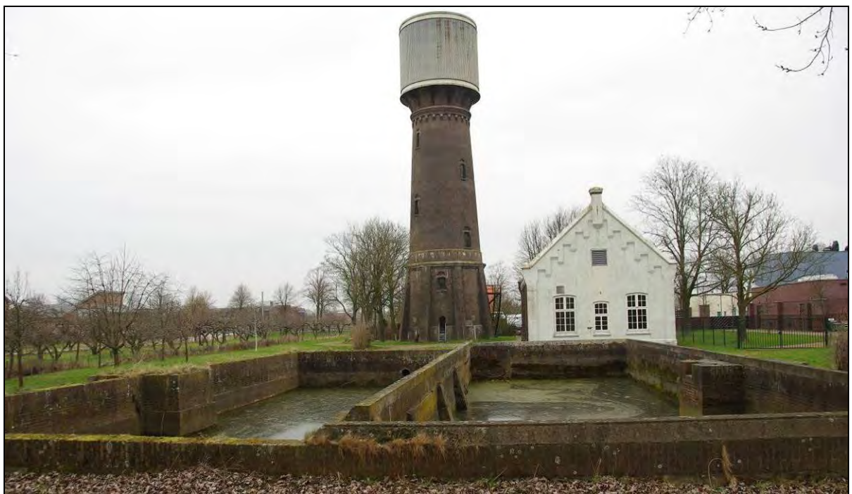
De watertoren, het pomphuis en de bezinkbakken.
