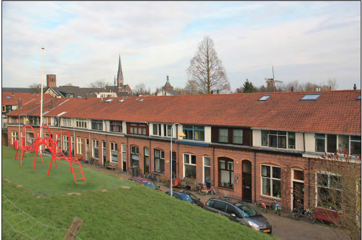
Arbeiderswoningen aan de Lekdijkstraat.
