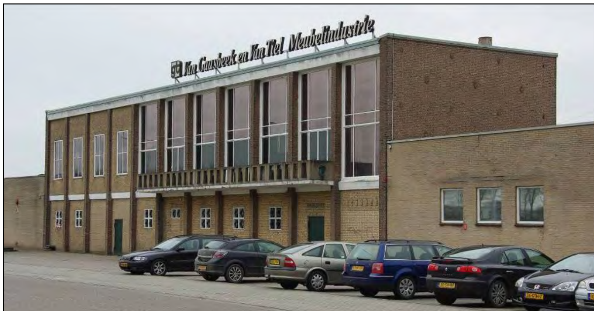
Fabrieksgebouw van Van Gaasbeek en Van Tiel.
