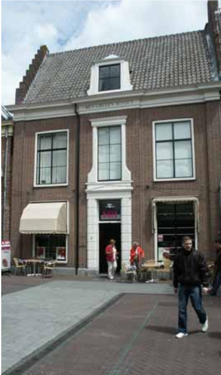
Etalages binnen de historische omlijsting
