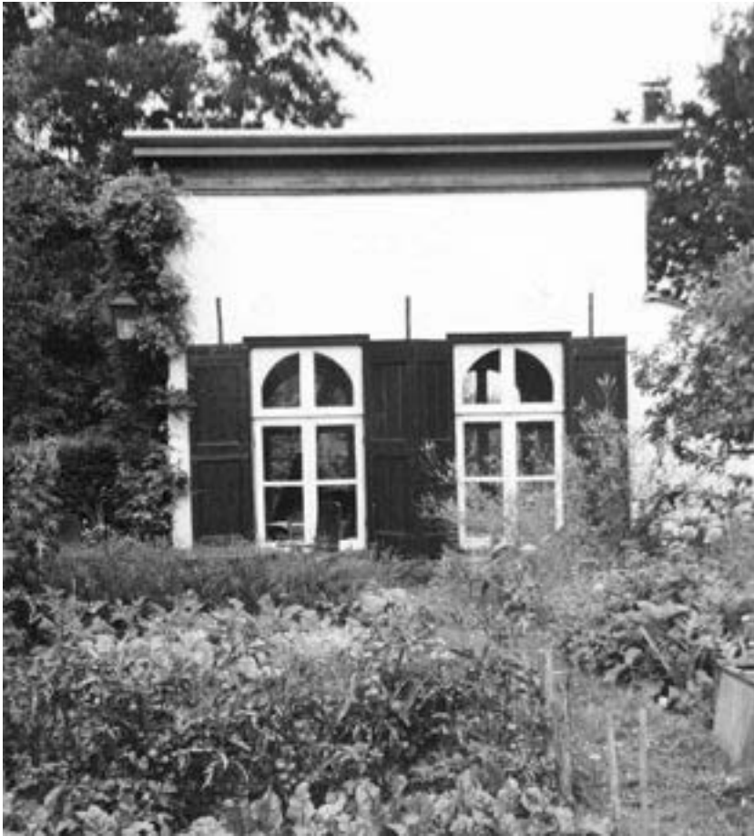
Een recente foto van het 'tuinhuisje van Mol' aan de Waldeck-Pyrmont-dreef, gebouwd rond 1875 in opdracht van notaris Van der Meer.
