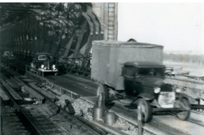
Herstelwerkzaamheden aan de brug direct na de oorlog. De noodpijlers zijn nog aanwezig. (Elisabeth Weeshuismuseum, Culemborg)
