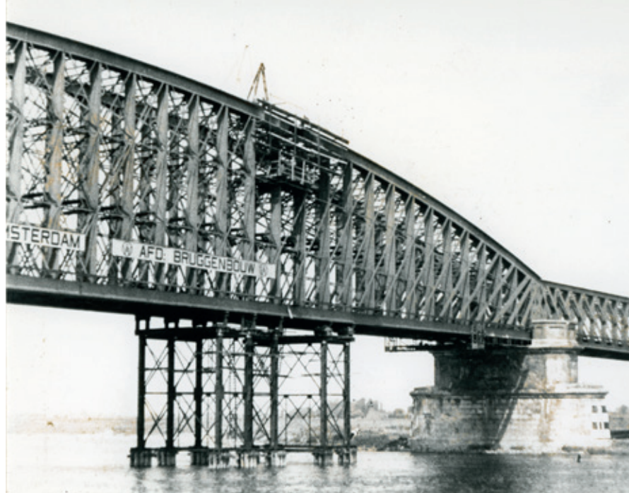
Herstelwerkzaamheden aan de brug direct na de oorlog. De noodpijlers zijn nog aanwezig. (Elisabeth Weeshuismuseum, Culemborg)
