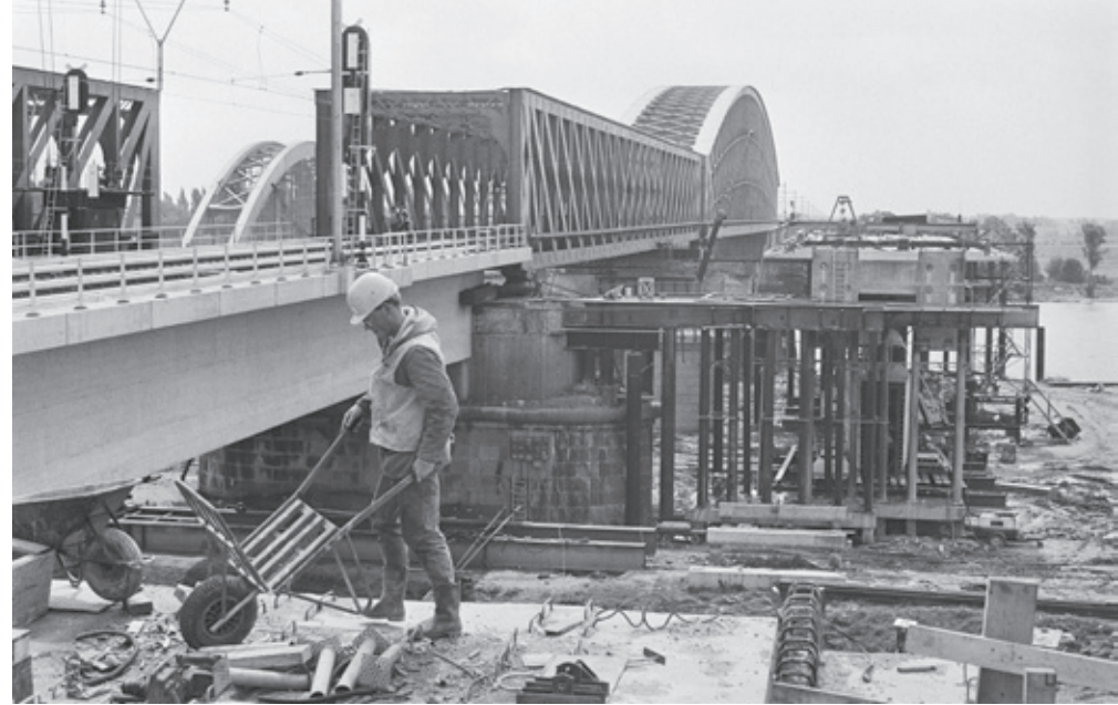
Juni 1982. Wat in 1867 met veel inspanning aan elkaar geklonken is, wordt nu met de snijbrander gesloopt. Rechts is een deel van de metalen aanbruggen vervangen door nieuwe betonnen bruggen. (links: P.W. van der Vlist, Huizen; rechts: Marcel Antonisse/Nationaal Archief, Den Haag)
