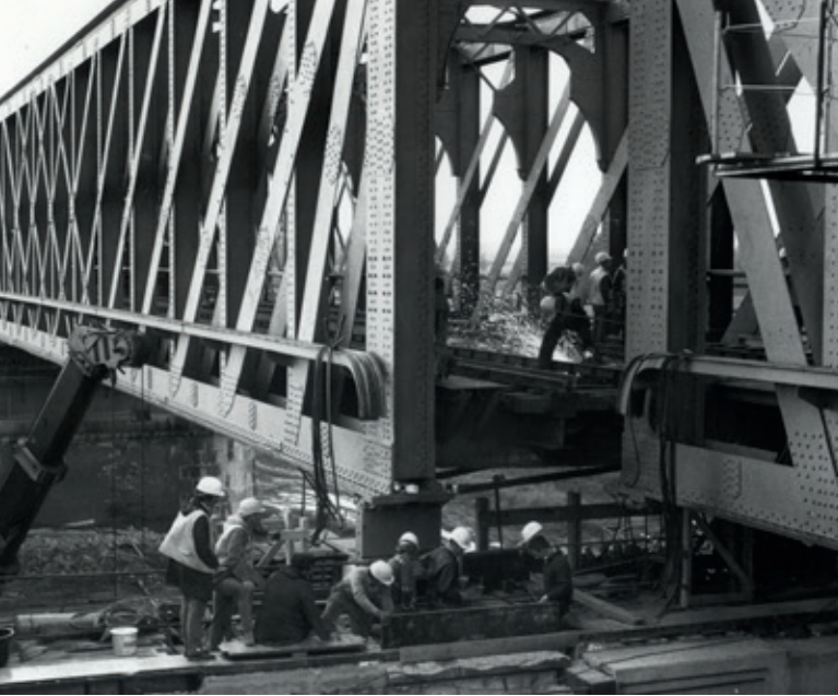
Juni 1982. Wat in 1867 met veel inspanning aan elkaar geklonken is, wordt nu met de snijbrander gesloopt. Rechts is een deel van de metalen aanbruggen vervangen door nieuwe betonnen bruggen. (links: P.W. van der Vlist, Huizen; rechts: Marcel Antonisse/Nationaal Archief, Den Haag)
