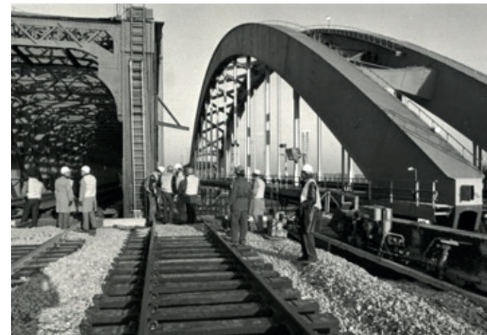
Juni 1982. Wat in 1867 met veel inspanning aan elkaar geklonken is, wordt nu met de snijbrander gesloopt. Rechts is een deel van de metalen aanbruggen vervangen door nieuwe betonnen bruggen. (links: P.W. van der Vlist, Huizen; rechts: Marcel Antonisse/Nationaal Archief, Den Haag)
