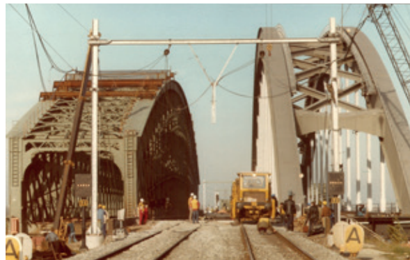
Juni 1982. Wat in 1867 met veel inspanning aan elkaar geklonken is, wordt nu met de snijbrander gesloopt. Rechts is een deel van de metalen aanbruggen vervangen door nieuwe betonnen bruggen. (links: P.W. van der Vlist, Huizen; rechts: Marcel Antonisse/Nationaal Archief, Den Haag)
