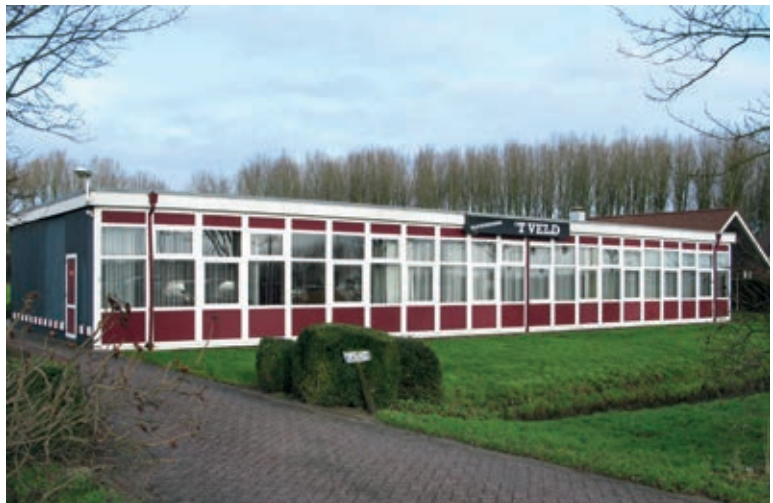
Wijkgebouw In ’t Veld aan de Rietveldseweg.
