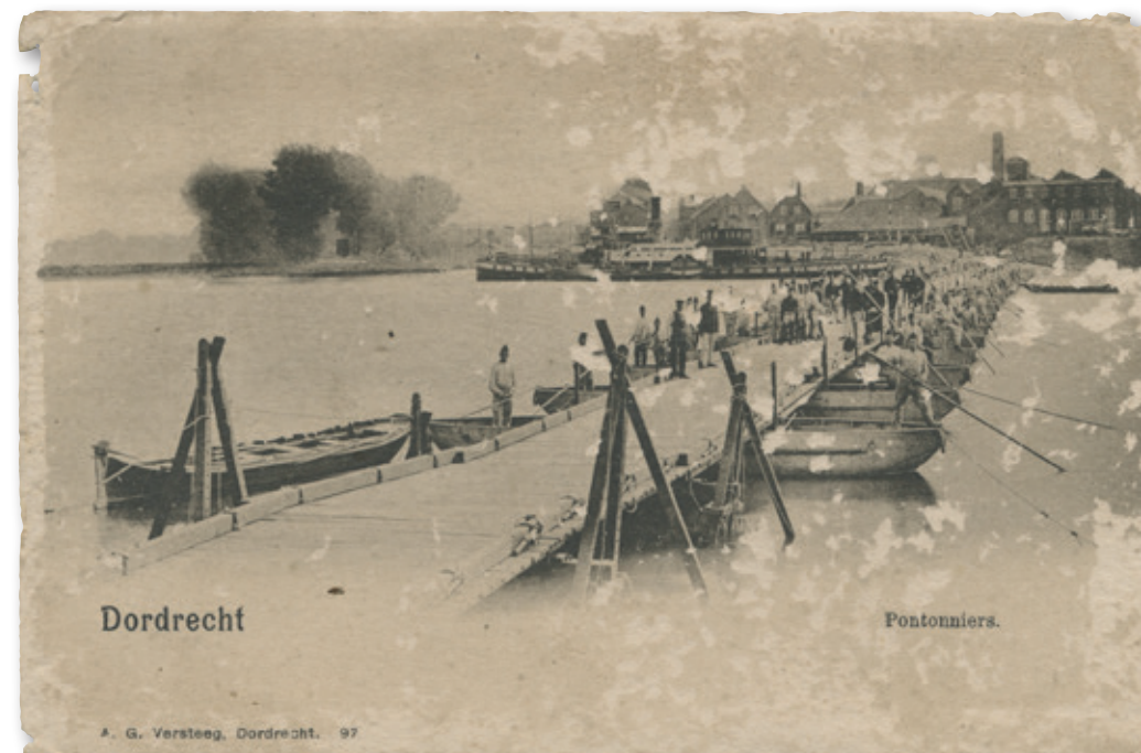
Pontonniers uit Dordrecht leggen een pontonbrug in de Lek bij Culemborg.
