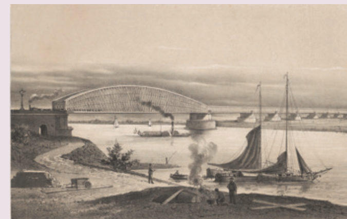
Lijnpad langs de Lek via de huidige Veerkade richting de speciaal gebouwde lijnpoort onder de spoorbrug. Afbeelding uit 1874.
