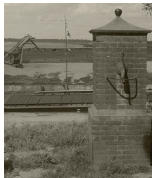
Koperen waterpomp op de Veerweg. De groen koperen restanten van deze bijzondere investering zijn nog zichtbaar. Het dak is vervangen door een kleiner exemplaar. Op de achtergrond links staat de hefinstallatie voor de boomstammen in het 'balkengat'. Foto uit 1950.
