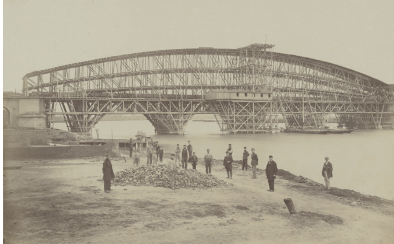
Bouw van de overspanning tussen de pijlers, augustus 1867. Foto van J.H. van Schönscheidt.
