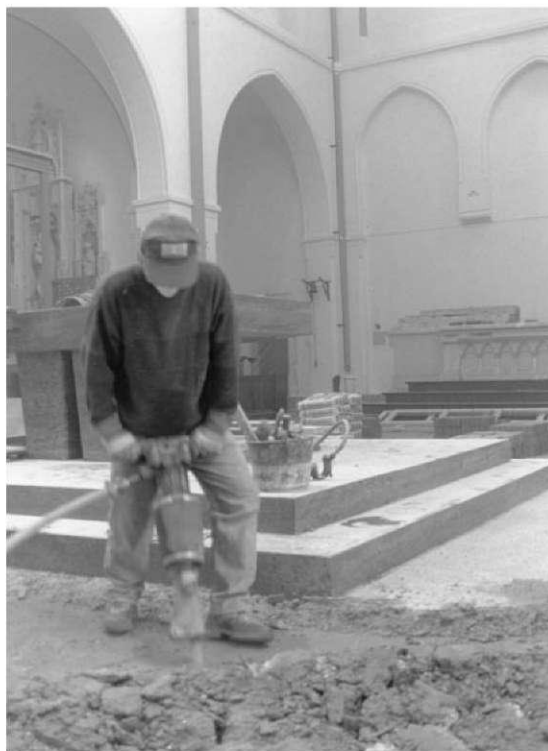
Werzaamheden in de kerk in 1992. Op de achtergrond de restanten van het hoogaltaar na de demontage van het orgel.
