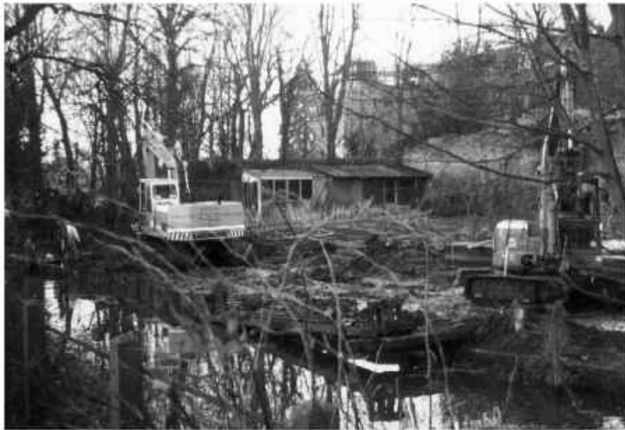
Het aanleggen van een wandelpad langs de stadsgracht. Dit pad verbindt de parkeerplaats van de polikliniek met het nieuwe stadskantoor. Rechts-achter een deel van de oude stadsmuur. Opname december 1998.
