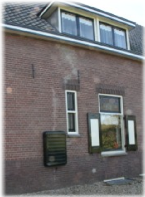
Afbeelding 16. De verzakte boerderij aan de Achterweg. De verzakking is zichtbaar door een scheur in het metselwerk.
