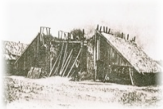
Afbeelding 8. Tot in het midden van de 20e eeuw was de veldoven in gebruik. Deze oven stond in Markelo en bestond uit twee zware muren, evenwijdig aan elkaar met aan de onderkant stookopeningen. Tussen deze muren werden de stenen gestapeld. Vervolgens werden de zijkanten en de bovenkanten afgedekt.
