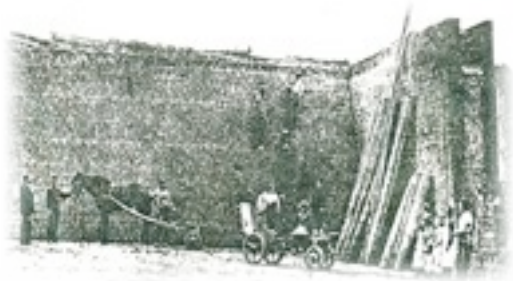
Afbeelding 9. De binnenkant van een grote veldoven in Wamel. De nog ongebakken stenen worden met een hittenkar naar binnen gereden.
