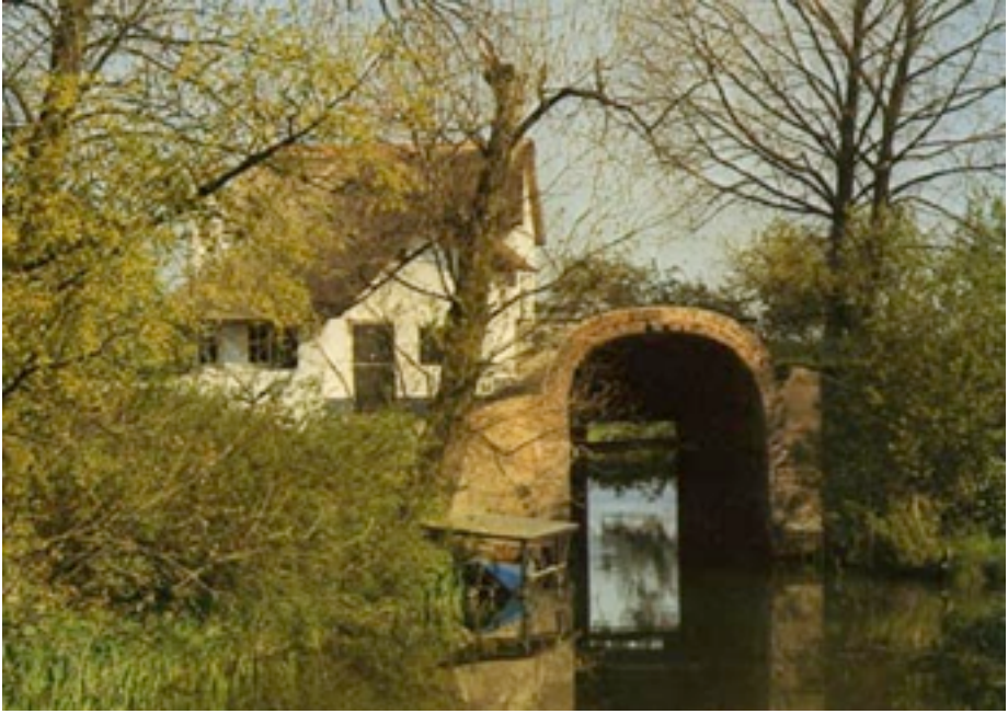
Afbeelding 29. Boutensteinse Sluis te Rumpt in het traject Culemborg-Zaltbommel.
