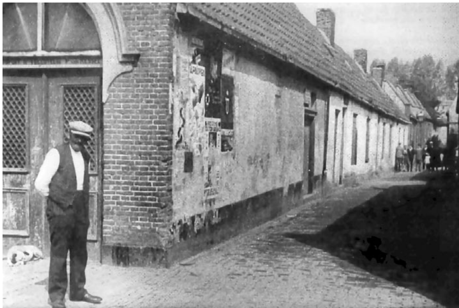
Het brandspuithuisje op de hoek van de Rozen- straat tegenover het huis van Jo Kuik.
